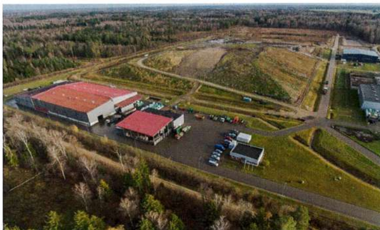
19 pav. Panevėžio regioninis sąvartynas
